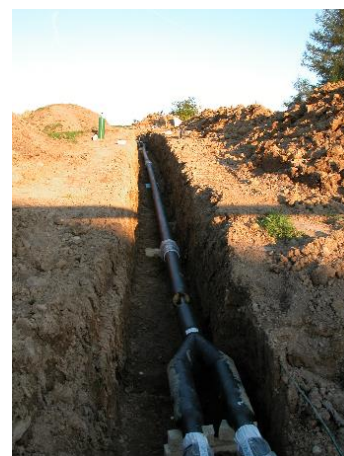
Verlegung von Fernwärmerohren
