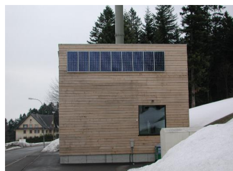
Außenansicht eines Biomasseheizwerkes
