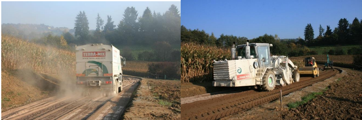
Aufbringung von Holzasche mit Streugerät (links), Vermischung mit dem zu stabilisierenden Boden mittels Fräse (rechts)
