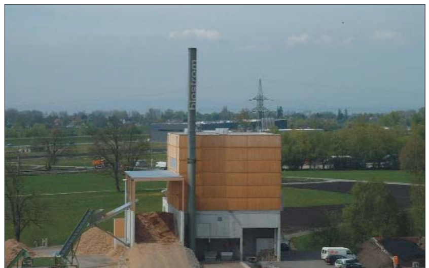
Bild 1. Die Biomasse-Kraft-Wärme-Kälte-Kopplungsanlage »Biotstrom« in Fussach, Österreich
